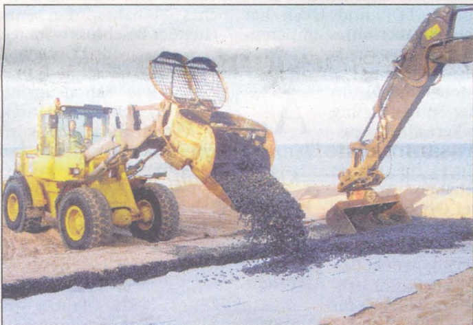
Ein Bagger kippt an der Westküste des Lister Ellenbogens ein neu entwickeltes Deckwerk in den Sand. Foto: dpa
